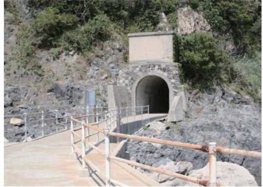
写真-10 改修後の様子
