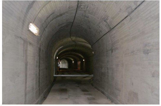
写真-2 トンネル内部
