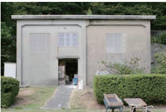
写真-7 大津島幼・小・中学校内に残る変電所跡
