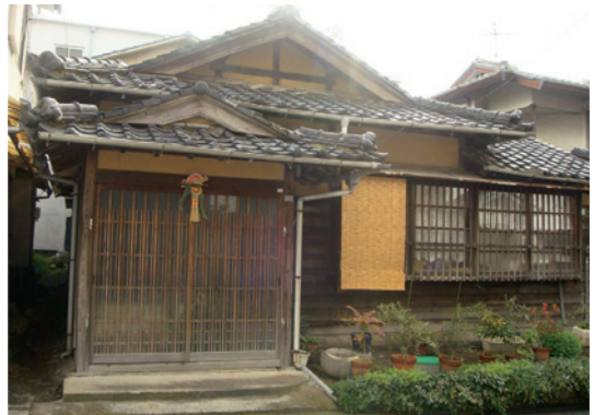
写真2 下見張りの例(久村家住宅)
