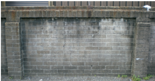
写真 8 控えのある鉾津煉瓦塀の例
