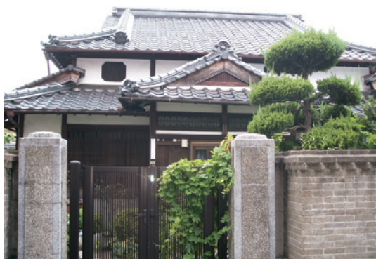
写真 4 下屋を持つ屋根の例（藤井家住宅）
