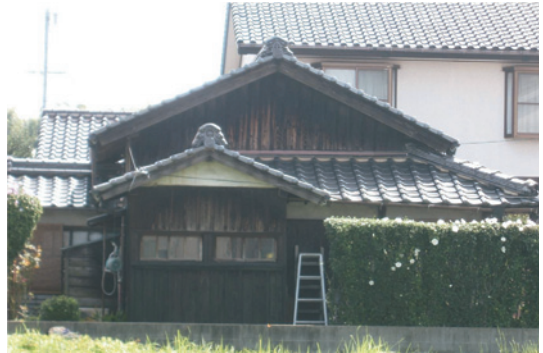
写真1 縦張りの例(恵木本家住宅)
